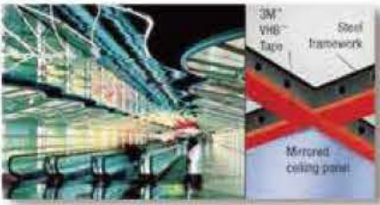
与螺钉相比, 使用3M™ VHB™ 胶带可将镜面天花板的面板固定在适当位置。这有助于其保持清洁、平滑的外观, 同时反射面也不会发生变形。
